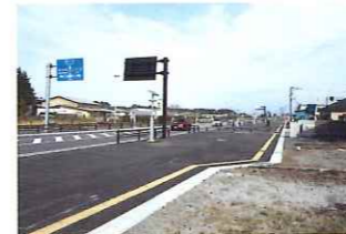
道の駅なみえ付近の風景。暮らしやすい街づくりに向けて開発が進む
